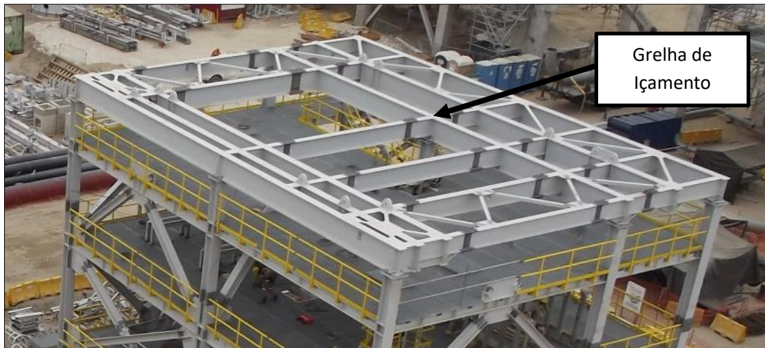
Figura 7 - Exemplo de grelha de içamento com diversos olhais sendo utilizada sobre um módulo a ser içado – Fonte: Arquivo da obra.
