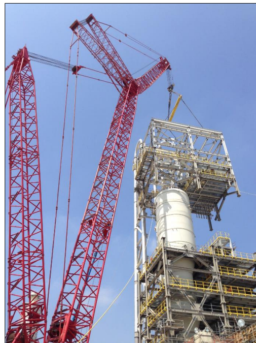
Figura 8 - Exemplo de projeto de arranjo de lingadas para içamento de um módulo utilizando grelha de içamento (esquerda). Foto da utilização deste arranjo (direita). Fonte: Arquivo da obra.
